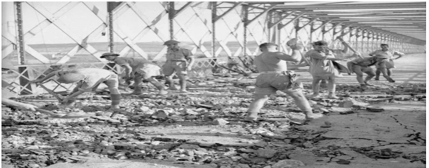
Genieri britannici riparano i danni al ponte di Primosole sul fiume Simeto dopo la sua conquista, nel luglio 1943. Il controllo dei ponti di Primosole e Malati era essenziale per consentire l'avanzata britannica nella piana di Catania e impedirne la distruzione da parte delle forze dell'Asse in ritirata. Foto del sergente Gladstone, No. 2 Army Film & Photographic Unit. Imperial War Museums.
